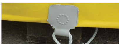
Kiinnityslenkki on hitsattu kiinni suojajepiteen ulkoreunaan.
