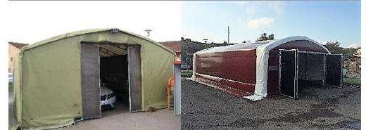
Oisolerad blir isolerad med ISO95.
